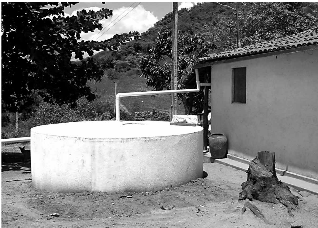
Cada reservatório tem capacidade para 16 mil litros, amenizando os efeitos da seca prolongada
